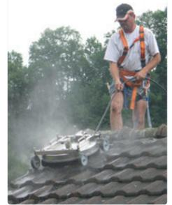
Laveurs tout inox, équipés d'un cadre renforcé leur assurant une très grande stabilité, réglables en hauteur, max. 33 mm et en largeur, max. 90 mm, munis de deux anses de sécurité prévues pour un arrimage par mousquetons. Nous vous conseillons l'usage d'un pistolet à commande au pied ST-550. Les laveurs sont dotés de 4 roulettes industrielles (125 mm). Max. 2.400 l/h / 120 °C
